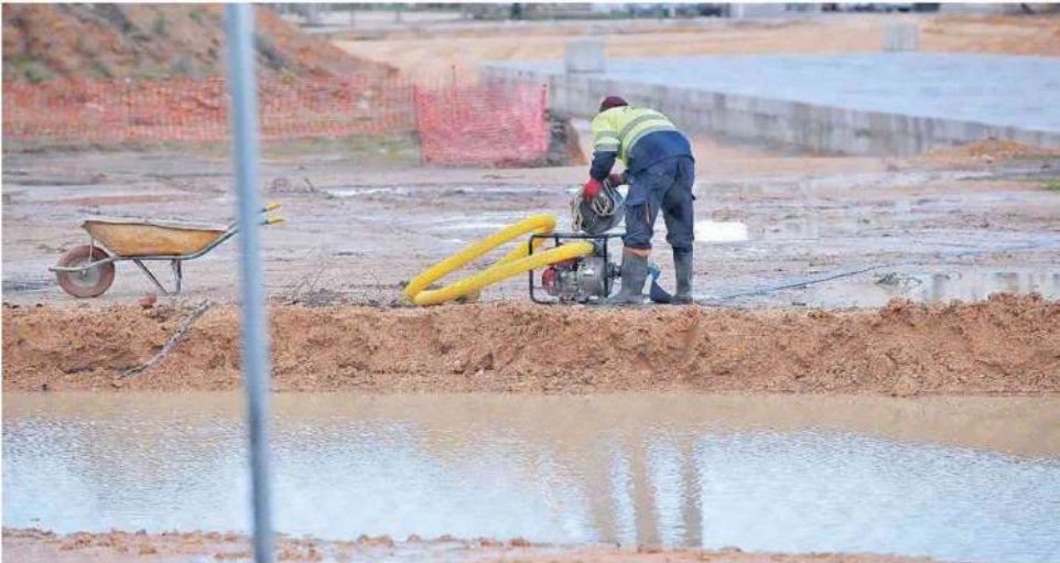
Un operario achica agua en el canal de María Cristina en Albacete
